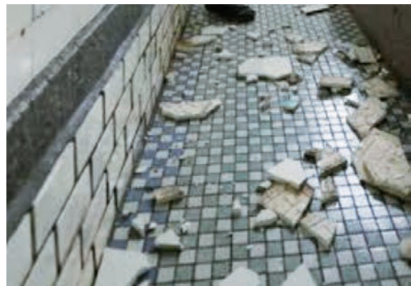
図1 剥がれ落ちた浴室のマジョリカタイル
