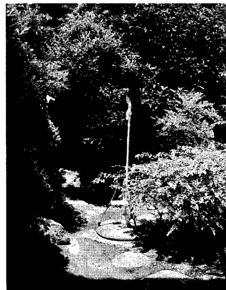
写真3. 温湿度センサー設置状況(外部設置例:E)
