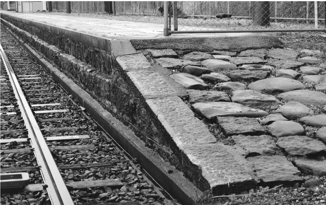
写真11 スロープの石畳 ホームの石積みに段がついていることもわかる
