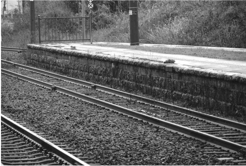
写真 14 自然石のままの笠石が残っている部分
