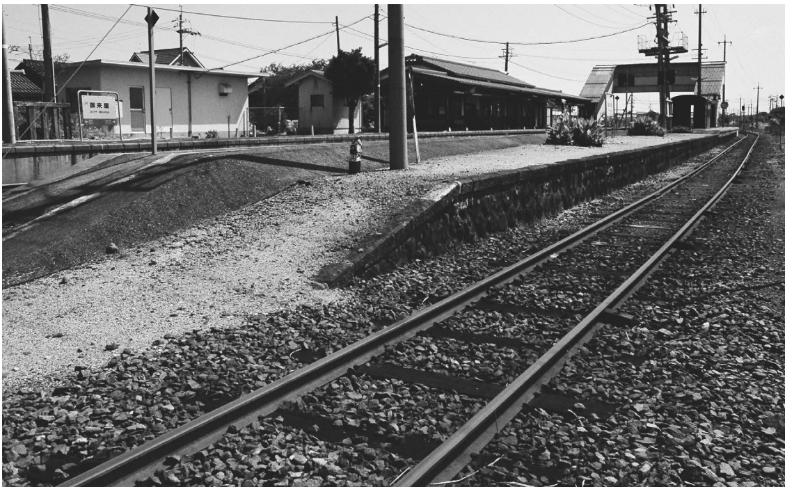
写真9 御来屋三番線 二番線がすみまでかさ上げしているのに対し反対側の三番線はホームの半分かさ上げされずに中央部分（休貨車転用の待合室あたり）だけをかさ上げて使っている
