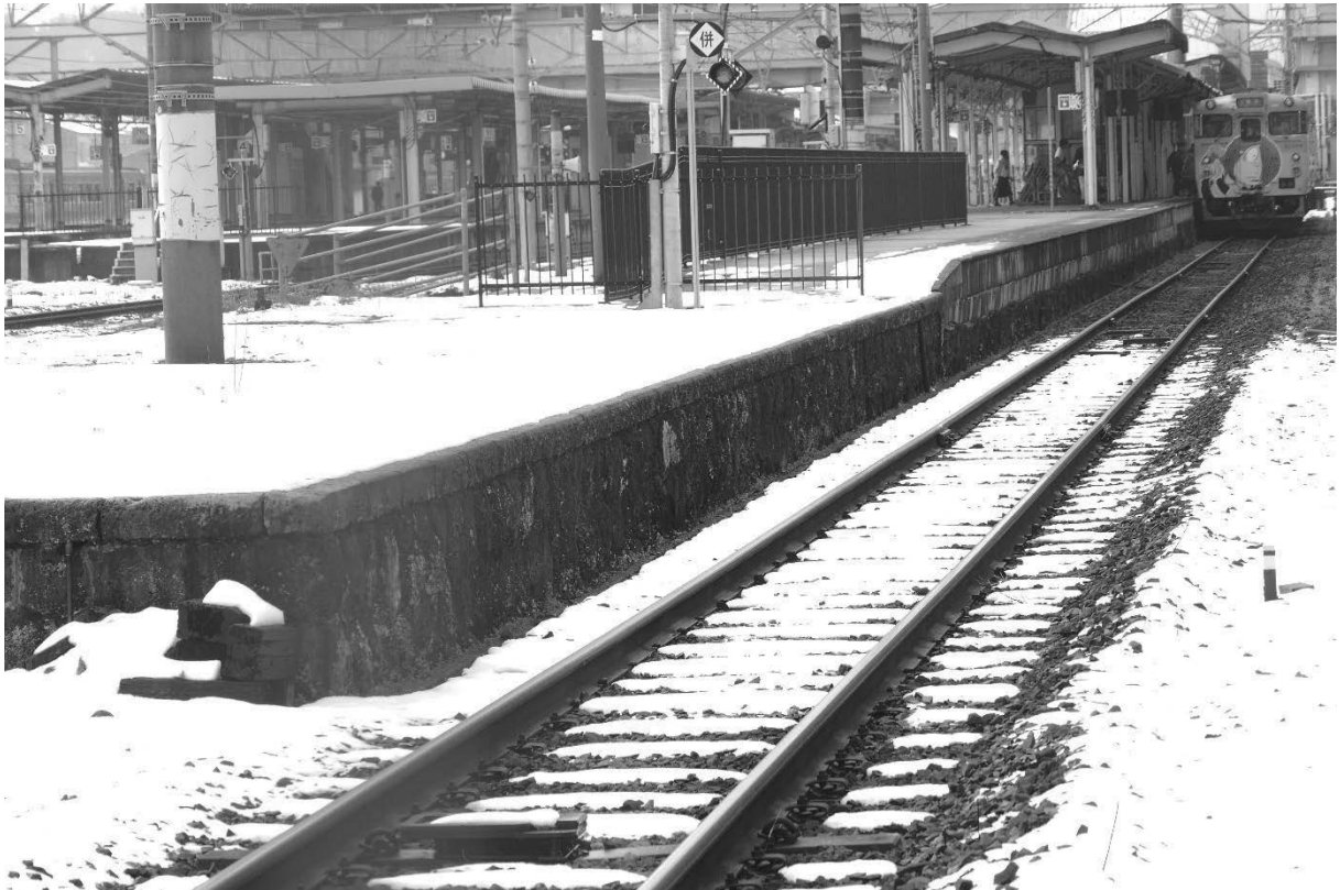
写真2 米子駅をダイテツ側から見る。かさ上げはホームとして使われている部分に行われている
