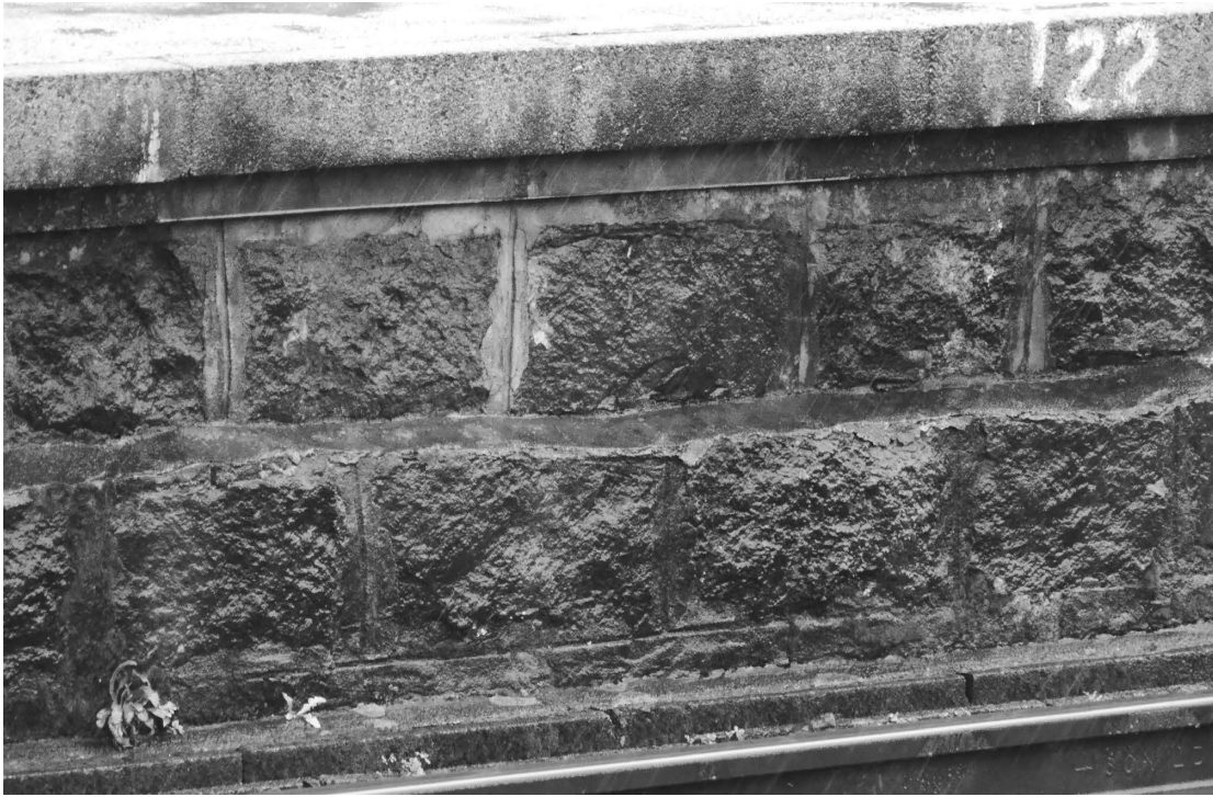
写真10 上から2段目部分が張り出して2段になっているのがわかる
